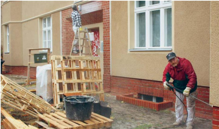
**Die Häuser strahlen wie neu, wenn nach den Dächern, Fassaden, Jalousien auch die Sockel vorbehandelt und mit Hochdruck abgestrahlt worden sind**
