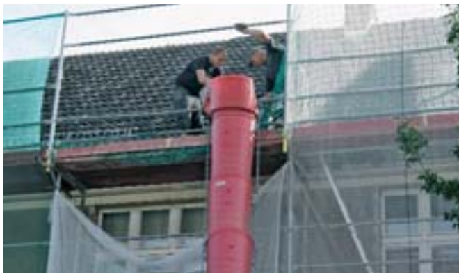
Das alte Dach in der Dreesstraße 48, 49, 50 wird abgedeckt.
