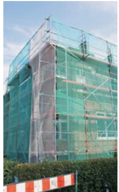
Das neue Projekt ist eingerüstet.
