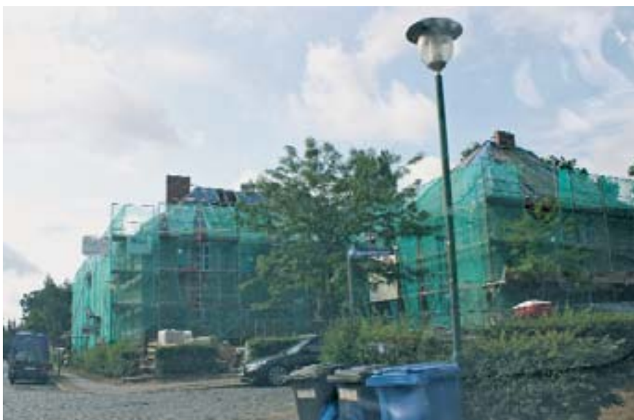
Die Kunersdorfer 33/Ecke Dreesstraße 28/29 ist schon weit fortgeschritten.
